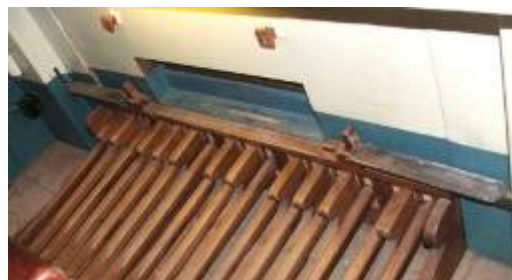
45–46. kép: 352 Redőnymozgató karok csukott, és nyitott redőnyállásnál; a bal oldali kar a Rohrwerk hez, a jobb oldali az Unterwerk hez készült.
