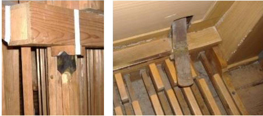
42–43. kép: 342 A szélcsatornába benyúló rézlap és az irányítására szolgáló billenőtalp
